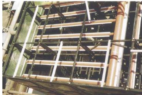
Multitubular para pulverização distribuição da água quente com baixa sobre pressão, indicado para todas qualidades de águas industriais.
