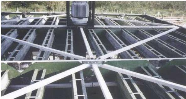
Canais abertos e fluxo por gravidade, com acesso para limpeza. Suportam em perfeita compatibilidade com enchimento RT águas com alto teor de sólidos suspensos.
